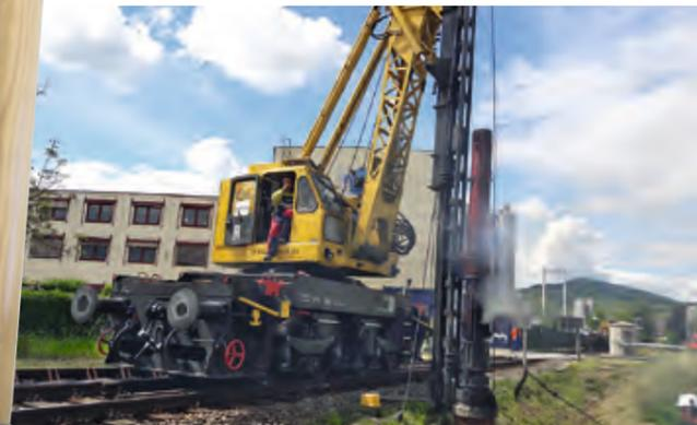
Diese Ramme kommt beim Einbau von Fundamentrohren für die zukünftigen Oberleitungsmasten zum Einsatz
